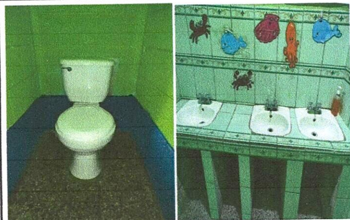
Foto 3: mejoramientos de area de servicios sanitario
