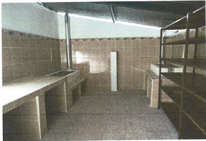
Foto1: mejoramiento de area de cocina
