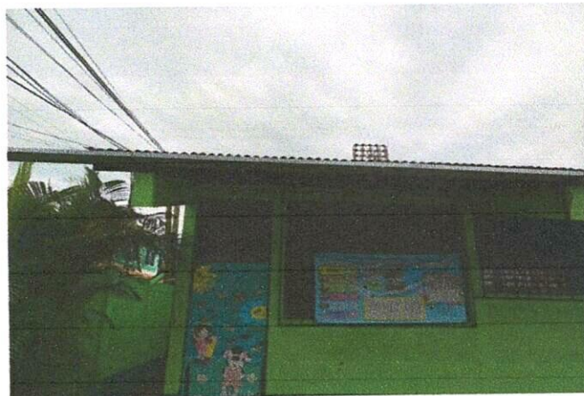
Foto 2: Mejoramiento de canales de agua pluvial
