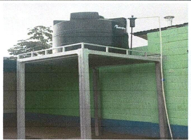
Foto 2: mejoramiento y colocacion de tinaco con su base
