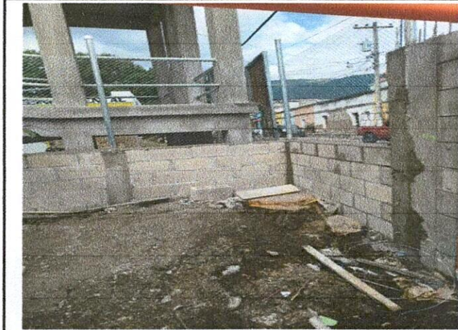
Foto1: mejoramiento de muro perimetral
